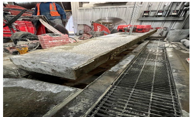
4A ID Fan Slab Removal
