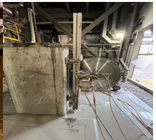
4A ID Fan Slab Removal
